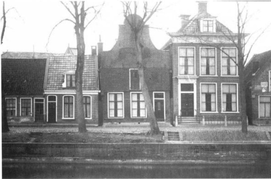
De Dijk te Dokkum, verdwenen panden t.b.v. de restauratie.
